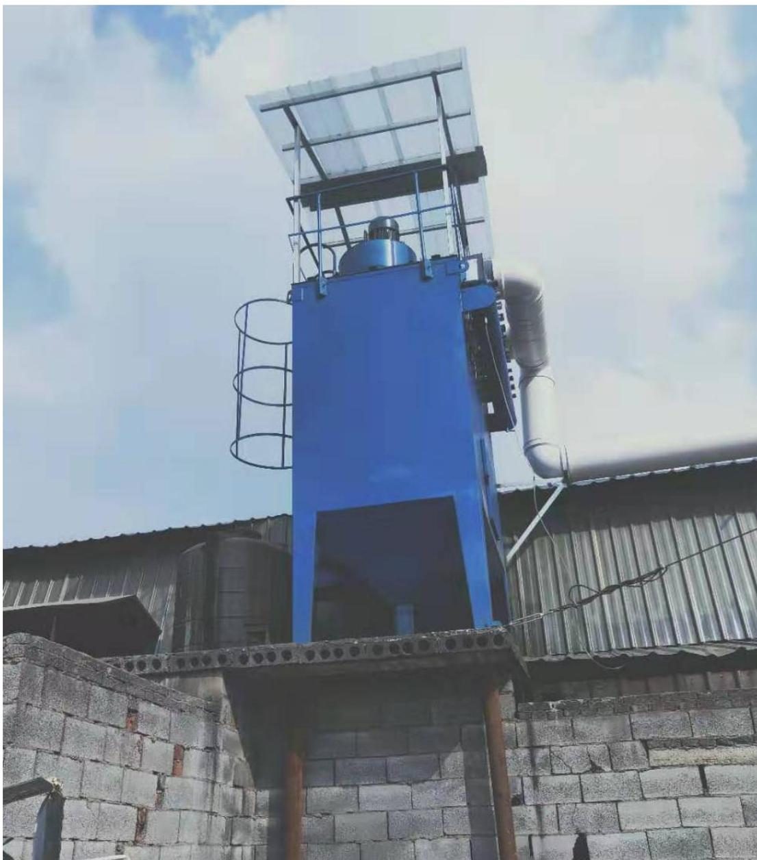
电熔炉配套悬挂式除尘器
